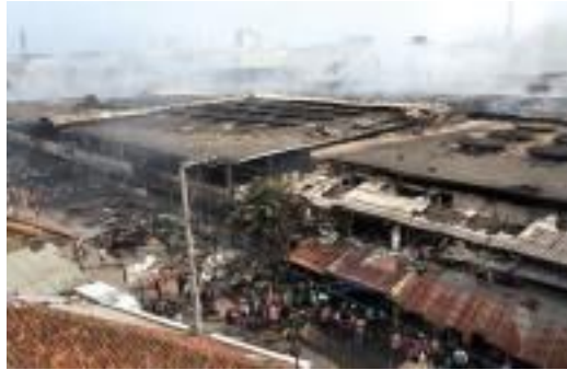
gambar 4.3 kondisi Pasar Johar sebelum revitalisasi
